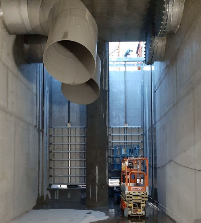
Kuva 3. Finnoon puhdistetun jäteveden purkautumiskanavaa nousukuilun ja meripurkutunnelin välistä
