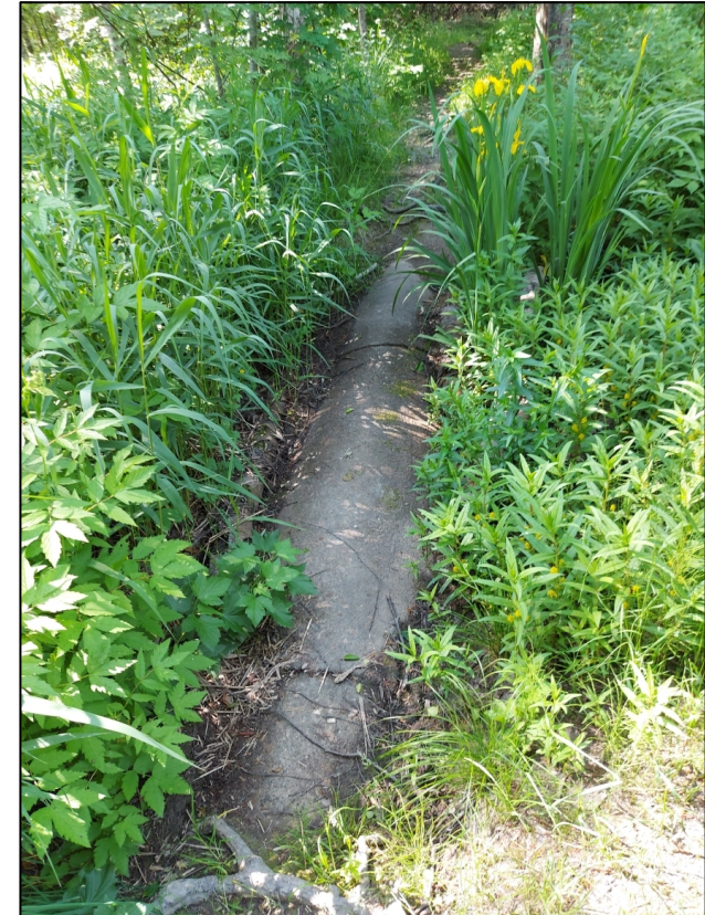
Viemäri 800B:n laki näkyvissä
