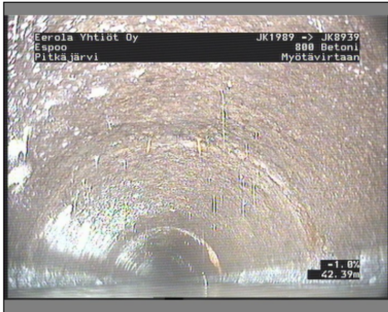
Kuva: JK1989_JK8939_011859_A.JPG, 00:02:09 42,39m, Vuoto 11 - 01 , 2 Veden tippuminen
