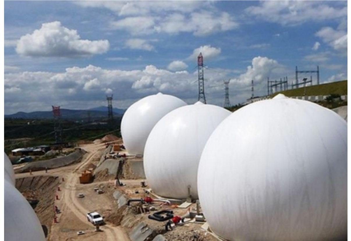
Esimerkkikuva kaksoiskalvoilla varustetuista kaasukelloista. Ämmäsuolle on suunniteltu yhtä kaasukelloa
