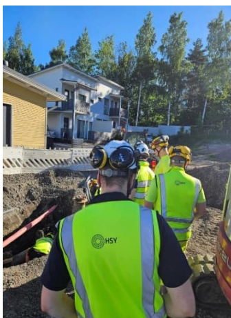
Kuva 10. Työturvallisuuskävely vesihuollon verkon työmaalla.
