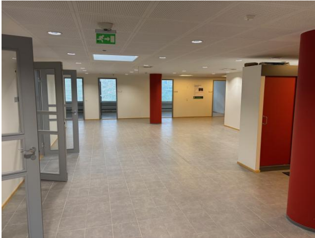
Sisääkäynnin vasemman puoleinen tila
